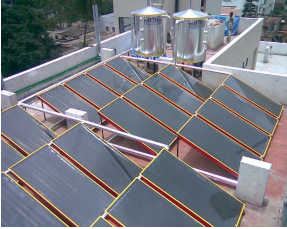
Güneş Kollektörlü Sıcak Su Sistemi
